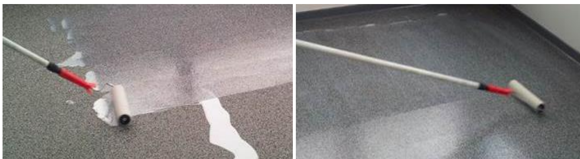
Versiegeln der Oberfläche
